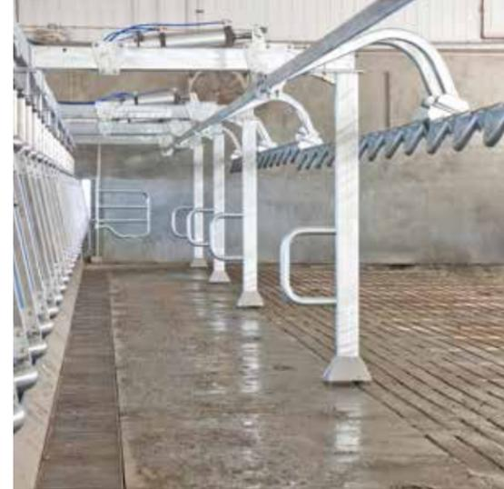
DeLaval HDHB mit Stand-Alone Melkzeugabnahme und horizontalem Versorgungskanal aus CN
