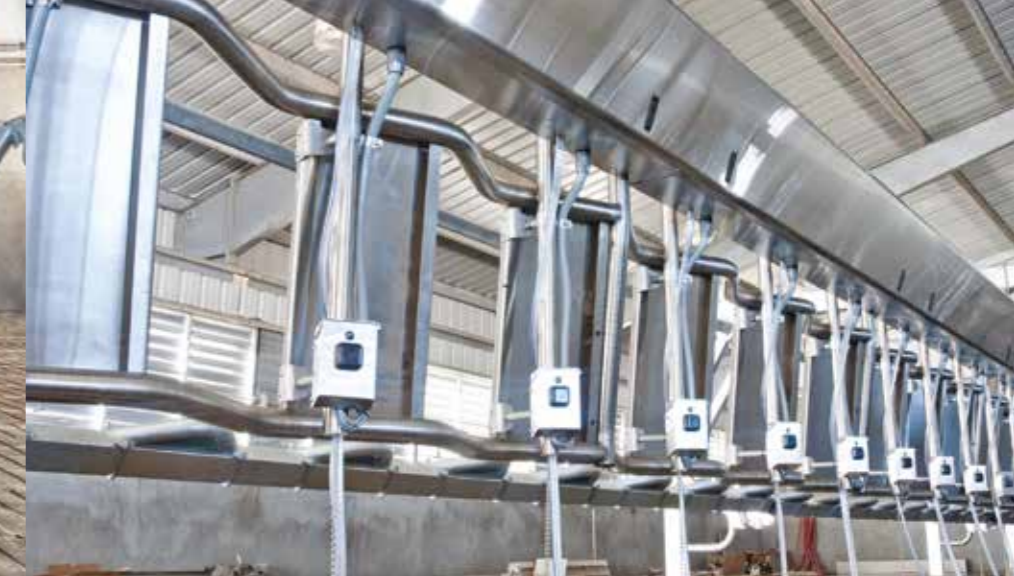
DeLaval HDHB mit Stand-Alone Melkzeugabnahme und horizontalem Versorgungskanal aus CN
