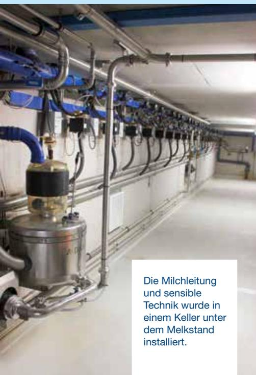
Die Milchleitung und sensible Technik wurde in einem Keller unter dem Melkstand installiert.
